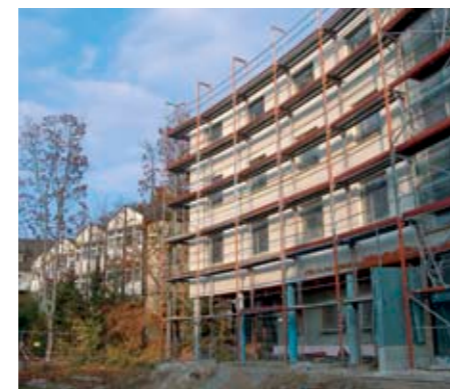
Der Neubau des Margarete-Blarer-Hauses
